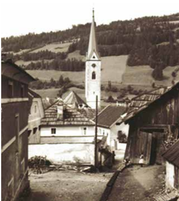
Arresthaus mit Hofmauer
