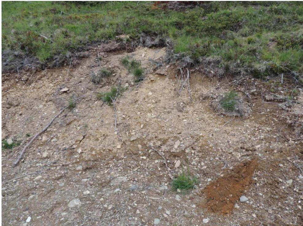
Abb 3: Gemischtkörniger Boden in der Böschung der Aufschließungsstraße (Moräne)
