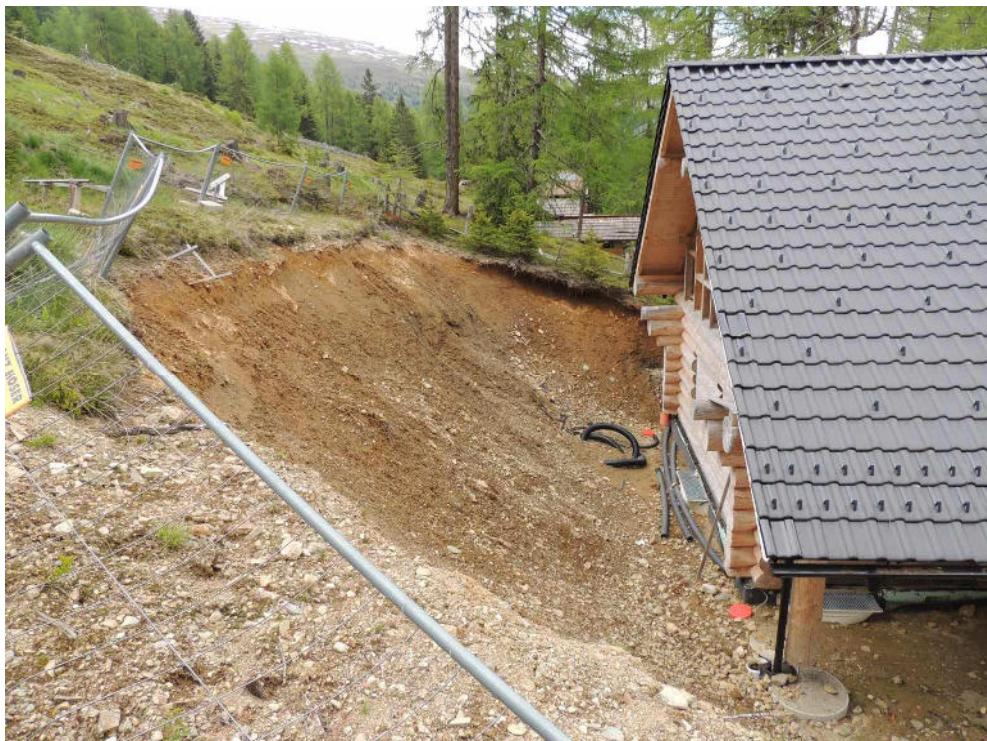
Abb.4: Ca. 4m hohe Baugrubenböschung im Lockergestein auf Parzelle 1012/11; Neigungsverhältnis 1:1
