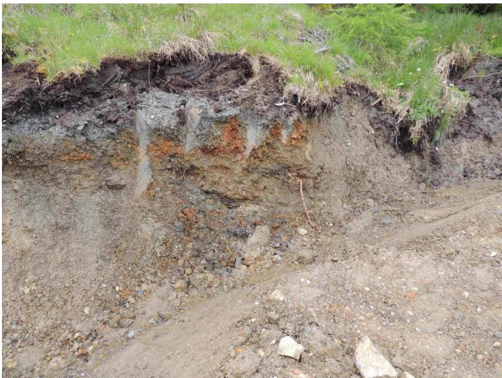
Abb.6: Ca. 1,5m hoher Hanganschnitt für Kanalkünnette in durchnässtem Boden mit organischen Ablagerungen im Bereich von M3 (31.5.2015); keine Nachböschungen während der Bauzeit
