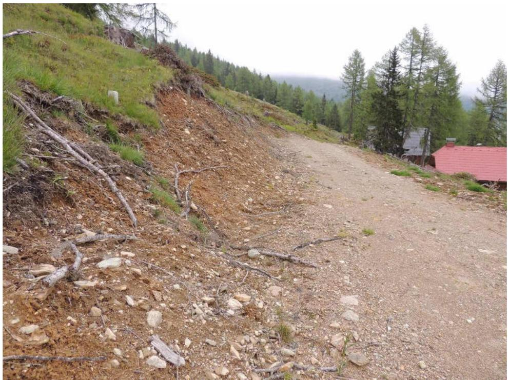
Abb.2: Derzeitiges Ende der Aufschließungsstraße (Juni 2015), oberhalb Parzelle 1012/10; 2,5m hohe standsichere Anschnittsböschung im Lockergestein mit Neigungsverhältnissen 2:3 bis 1:1
